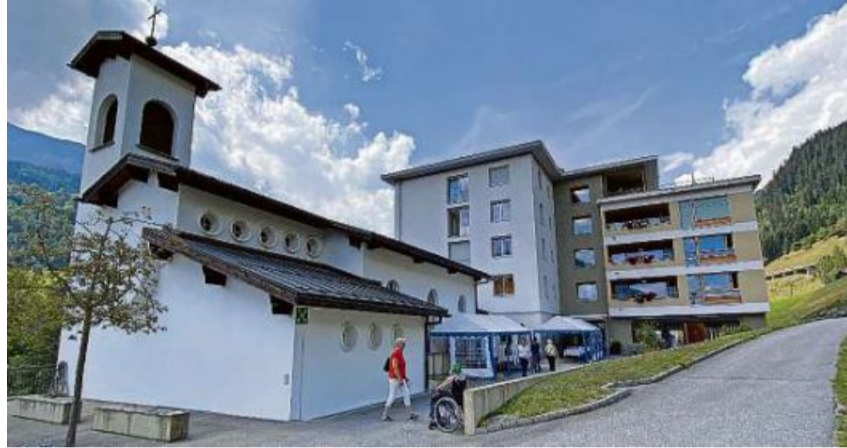
La Casa Sogn Giusep a Cumpadials ei vegnida engrondida (dretg) e renovada.
